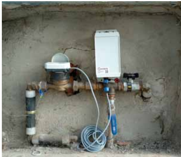
FIGURA 5. Datalogger IoTsens conectado a una salida de pulsos.
